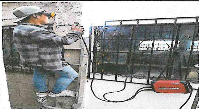
Foto 1. Colocación de balcones en la parte de atrás del establecimiento.
