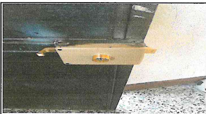
Foto 3. Cambio de chapas en algunas puertas que necesitan mantenimiento para la seguridad de los materiales que tienen los docentes.
