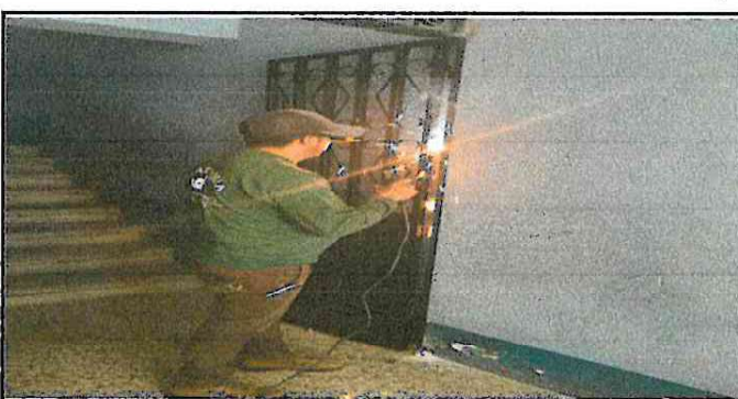
Foto 6. Colocación de un portón de emergencia para seguridad de la entrada del edificio escolar..
