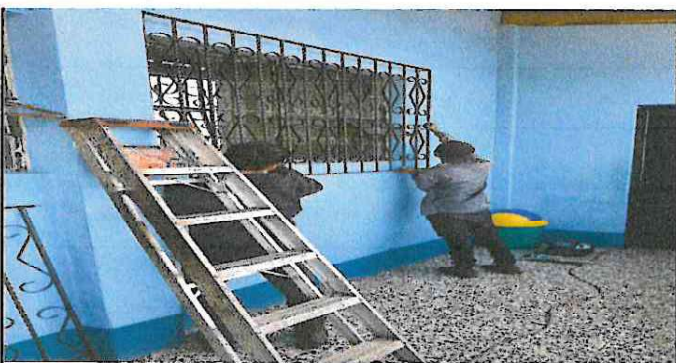
Foto 5. Colocación de balcones en las ventanas de los corredores para seguridad de las aulas.
