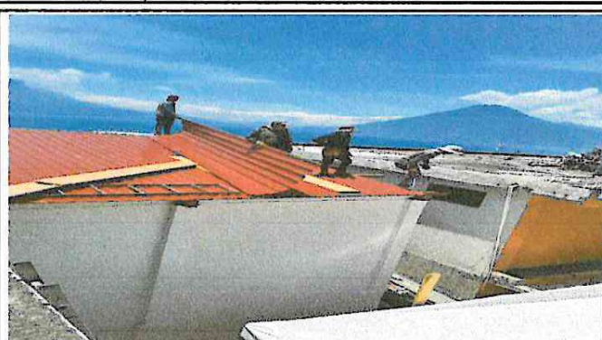
Foto 2. Cambio del techado por deterioro de las anteriores y por mucho goteo cuando llueve.
