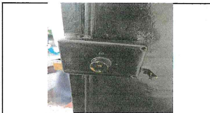
Foto 3: Sustrucción de chapas de aulas
