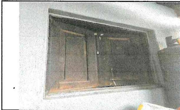
Foto 7: Colocación de balcones en ventanas
