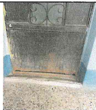
Foto 10: Sustitución de puerta de aula
