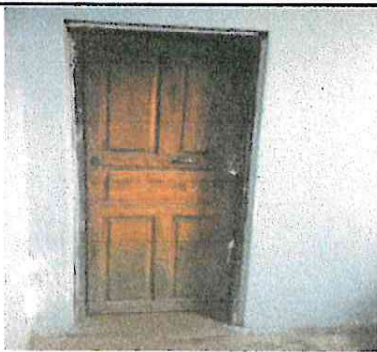
Foto 9: Sustitución de puerta de cocina
