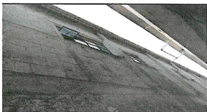
Foto 4: Colocación de balcones, tercer nivel
