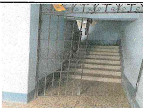
Foto 11: Sustitución de puerta salida de emergencia
