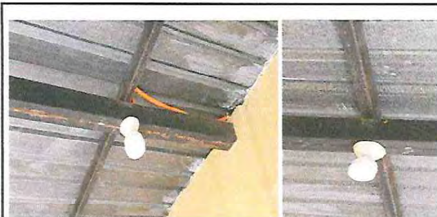
Foto 12. Reparación y sustitución de lampas tipo LED
