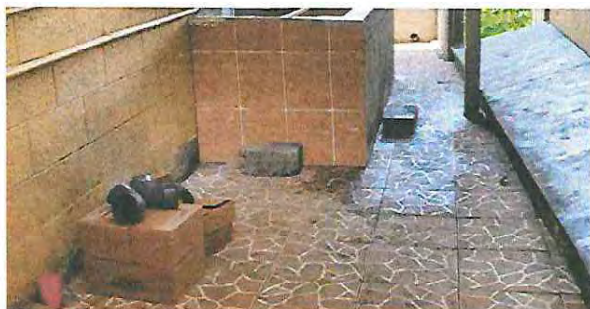
Foto 13. Sustitución de Piso de cerámico
