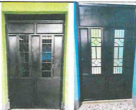
Foto 3. Mantenimiento de 50 puertas de Metal.
