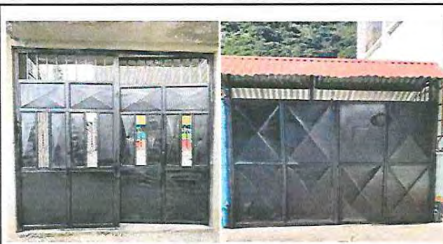
Foto 8. Mantenimiento a portones de metal.
