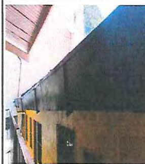
Foto 6. Reparacion de Canal de Metal
