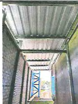
Foto No. 2: Sustitución de estructura de soporte de madera, por metal
