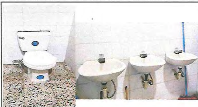
Foto 7: Sustitución de inodoros y accesorios de lavamanos e inodoros
