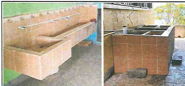
Foto: 9 Sustitución de azulejo en pileta.
