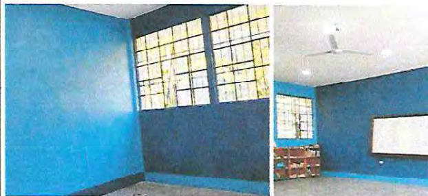
Foto 14. Pintura en aulas
