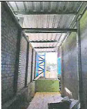
Foto No. 2: Sustitución de estructura de soporte de madera, por metal
