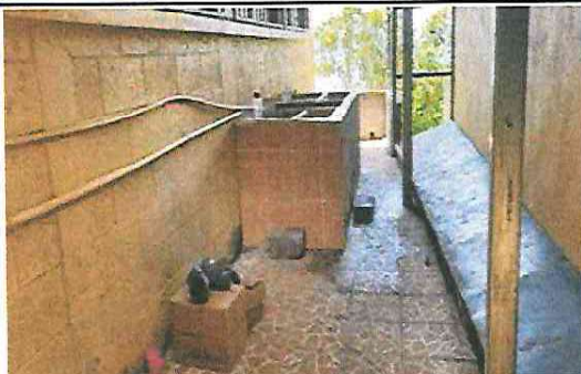
Foto 13. Reparación de piso de ceramica
