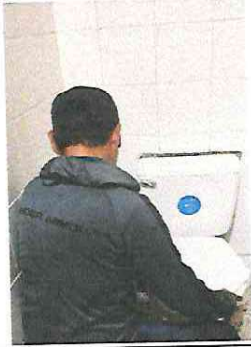
Foto 7: Sustitución de inodoros y accesorios de lavamanos e inodoros
