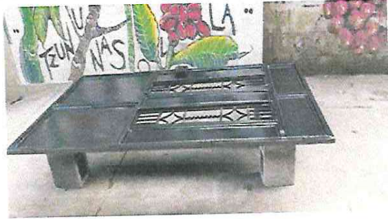
Foto 8. Mantenimiento a portones de metal.
