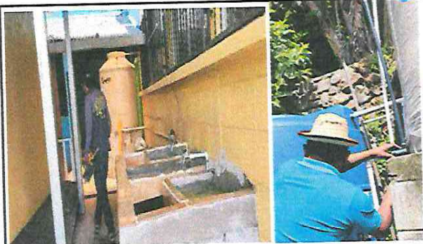
Foto 10. Reparación de Red de Agua potable
