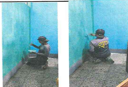
Foto 14. Pintura en muro interior
