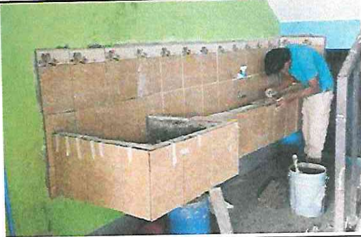
Foto: 9 Sustitución de azulejo en pileta.
