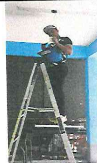
Foto 12. Reparación y sustitución de lampas tipo LED
