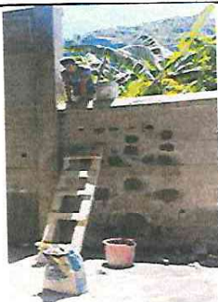
Foto 11. Reparación de muro perimetral de block
