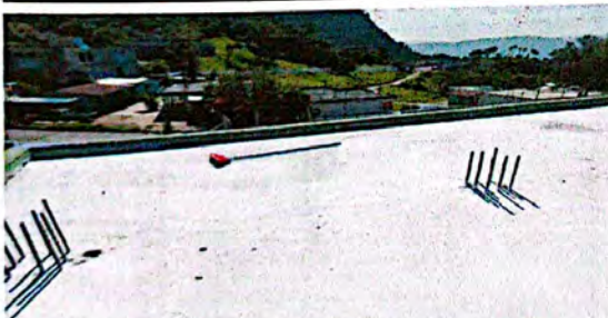
Foto 9: VISTA LATERAL DEL EMPAÑUELADO DE LOSA
