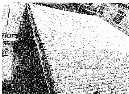
Foto 3: Láminas con agujeros cambiadas, ahora techo nuevo.
