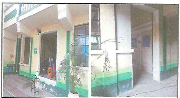
Foto 6: AMPLIACION DE PUERTAS EN 1er y 2do NIVEL: Conclusion de puertas de 2 metros por 1. metro, con terminados y acabados.
