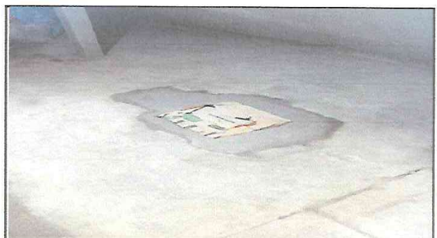
Foto 4: SUSTITUCION DE CAJAS DE REGISTRO: Fase concluida de sustitucion de cajas de registro con instalacion de drenaje para pileta de uso diario, con tapadera de concreto
