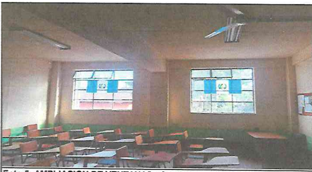
Foto 5: AMPLIACION DE VENTANAS: Conclusion de 2 ventanas de 1.50 centimetros por 1.64 centimetros, remodelacion con terminados y acabados
