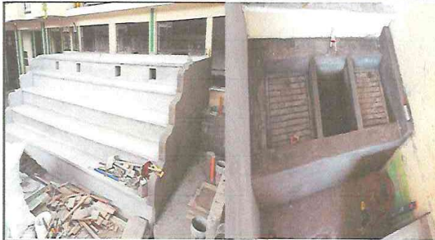
Foto1: LOZA DE PATIO DE: Fase concluida en formacion de bodega y remozamiento de Gradas y conclusion de pileta artesanal con formacion de lavaderos de 80 cms. cada lavadero
