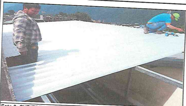
Foto 3: CUBIERTA DE LAMINA: Colocación de laminas troqueladas y lamiluz para evitar la caída de agua pluvial hacia el Establecimiento e instalación de canal de tubo plástico sobre loza para salida de aguas pluviales
