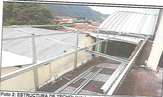
Foto 2: ESTRUCTURA DE TECHO: Instalación de Postes de metal y costaneras para formación de base de 4 metros de ancho por 10 metros de largo para colocación de lamina troquelada.
