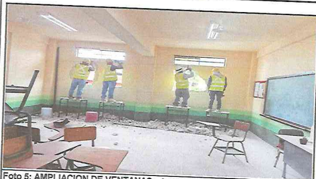
Foto 5: AMPLIACION DE VENTANAS: Ampliación de 2 ventanas de 1.50 centímetros por 1.64 centímetros, perforación de block, remodelación con terminados y acabados, Retiro de ripio.
