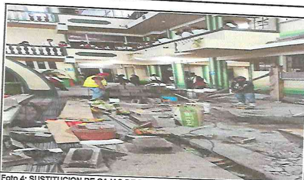
Foto 4: SUSTITUCION DE CAJAS DE REGISTRO de 80 cms 2 cada caja por 60 cms de fondo, sustituir cajas y tubos de drenaje desde la pila, picado de concreto, remodelación y terminados.
