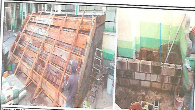
Foto 1: LOZA DE PATIO DE de 1.50 x 7 mts. de largo: total 10.50 mts 2 , levantado de block laterales de graderio y ventanas, total 21 mts para espacio de Bodega, ampliación de 4 gradas de 45x50 cms. total 28 mts, Total en mts 2 y lineales: 59 mts con 50 cms, e instalación de pileta Artesanal con 6 mts. de largo por 1 mt. de ancho con 01 mt de fondo, con formación de 6 lavaderos de 80 cms. cada lavadero
