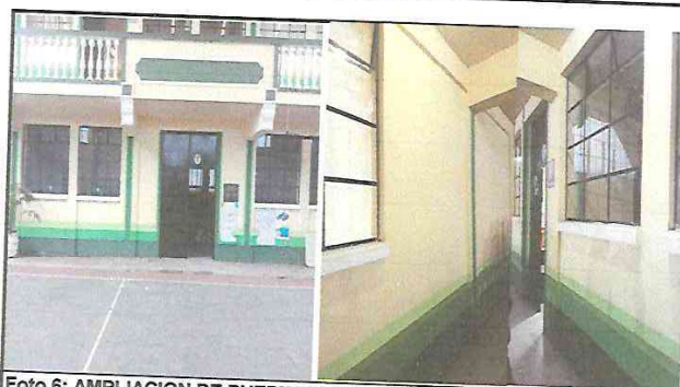
Foto 6: AMPLIACION DE PUERTAS EN 1er y 2do NIVEL: Ampliación de 4 puertas de 2 metros por 1. metro, instalación y perforación de block, remodelación con terminados y acabados, Retiro de ripio
