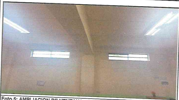
Foto 5: AMPLIACION DE VENTANA: Ampliación de 2 ventanas de 1.50 centímetros por 1.64 centímetros, perforación de block, remodelación con terminados y acabados, Retiro de ripio.
