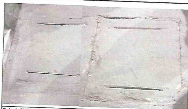
Foto 4: SUSTITUCION DE CAJAS DE REGISTRO de 80 cms2 cada caja por 60 cms de fondo, sustituir cajas y tubos de drenaje desde la pila, picado de concreto, remodelación y terminados.
