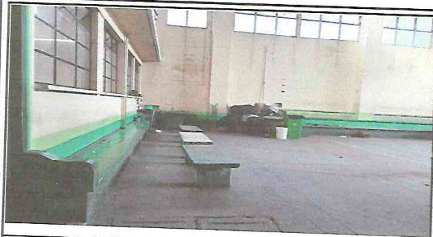
Foto 1: LOZA DE PATIO DE 1.50 x 7 mts. de largo: total 10.50 mts2, levantado de block laterales de graderio y ventanas, total 21 mts para espacio de Bodega, ampliación de 4 gradas de 45x50 cms. total 28 mts, Total en mts2 y Lineales: 59 mts con 50 cms, e instalación de pileta Artesanal con 6 mts. de largo por 1 mt. de ancho con 01 mt de fondo, con formación de 6 lavaderos de 80 cms. cada lavadero
