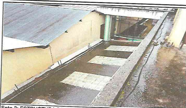
Foto 2: ESTRUCTURA DE TECHO: Instalación de Postes de metal y costaneras para formación de base de 4 metros de ancho por 10 metros de largo para colocación de lamina troquelada.
