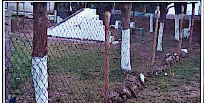
Foto 4: Circulación provisional con malla en mal estado en mal estado
