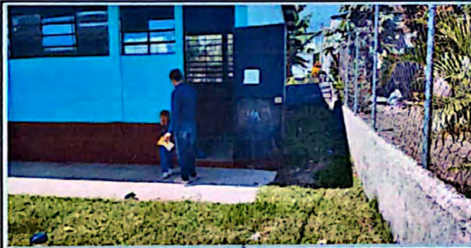
Foto 3: Circulación de block y maya galvanizada
