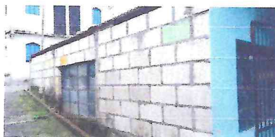
REPARACIÓN DE COCINA POR EL MAL ESTADO DEL LUGAR
