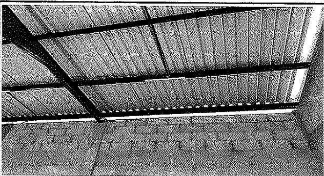
Foto 3: Culminación del trabajo de electricidad, colocación de las candelas led.
