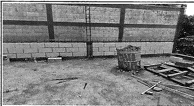
Foto 1: inicio de la sustitución de los muros del aula.
