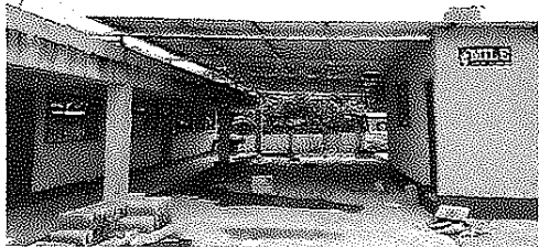
Culminación de techado de lamina de 5 mts de ancho x 15 mts largo.
