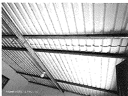
Culminación de la instalación de laminas troqueladas en la cocina con medidas de 5 x 5 cuadrado.
