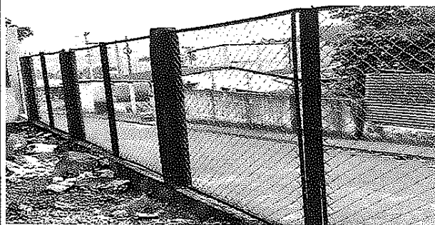
Culminación de la sustitución de malla en mal estado.
