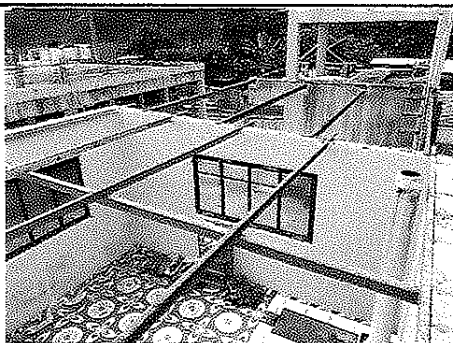
Se procede a la colocación de laminas troqueladas de 5 x 5 metros cuadrados por la filtración de aguas pluviales.
