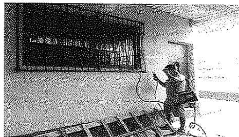
INSTALACIÓN DE BALCON DEBIDO A LA FALTA DE SEGUIRDAD DE 2.15 X 2.50
