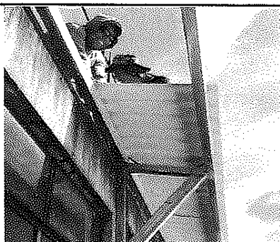
Instalación de pestaña en la parte trasera de tres aulas debido a debido a la caída dea aguas pluviales de 60 cm x 24 mts de largo.
