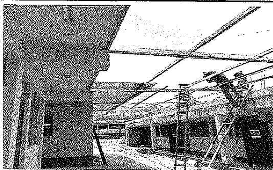
Instalación de Techado de lámina de 5 X 15 mts.
