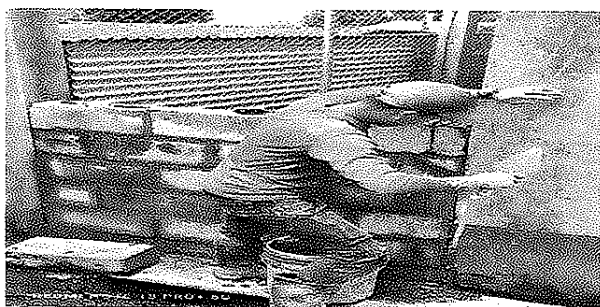
Sustitución de malla por una pared de Block.
