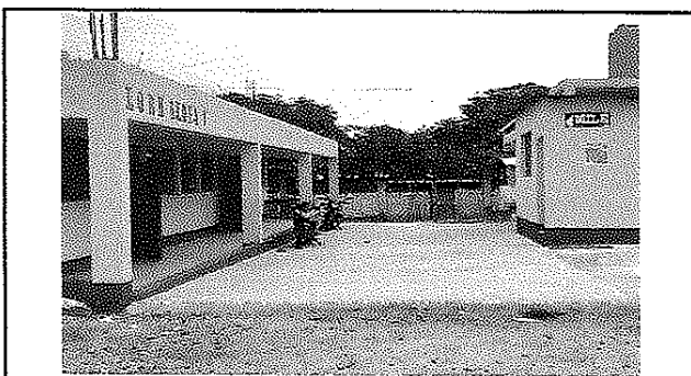
Instalación de Techado de lámina de 5 X 15 mts.
