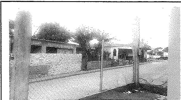
Sustitución de malla por una pared de Block.
