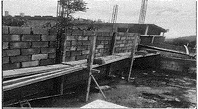
Foto 2: Pared deteriorado en proceso de reparación
