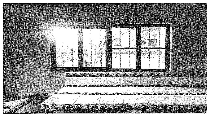
Foto 6: Ampliación y sustitución de Ventana para mejorar la iluminación y ventilación.
