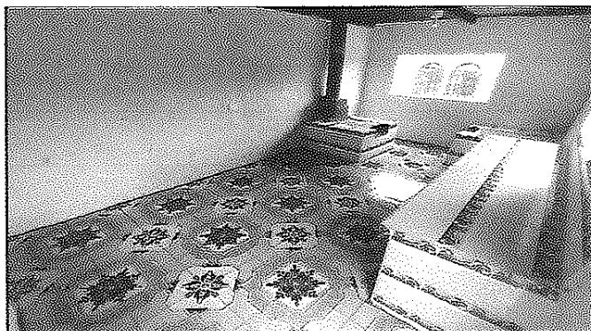
Foto 10: Piso sustituido en su totalidad (piso cerámico).
