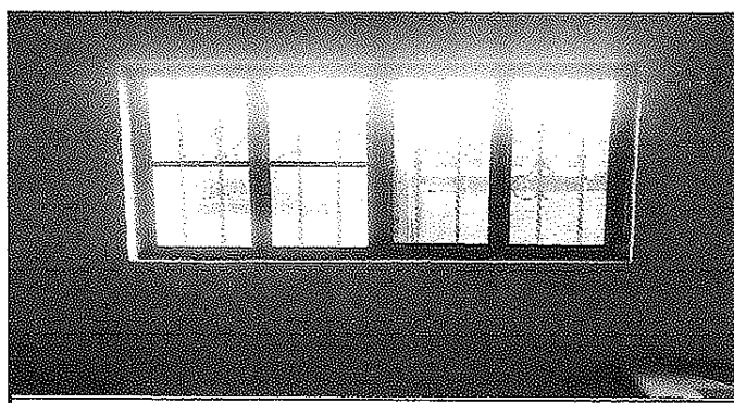
Foto 5: Ampliación y sustitución de Ventana para mejorar la iluminación y ventilación.
