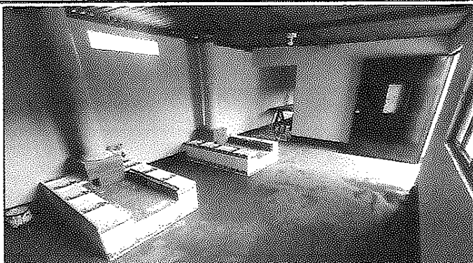
Foto 7: Repello en paredes y habilitación de puerta para comunicación entre ambas cocinas.
