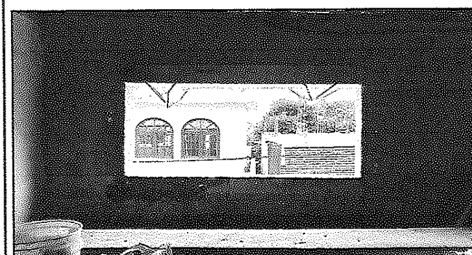
Foto 5: Ampliación de Ventana para mejorar la iluminación y ventilación.
