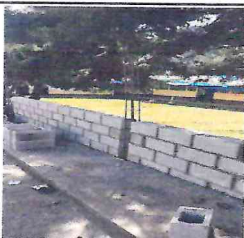
foto 3: Levantado de block frente la escuela.
