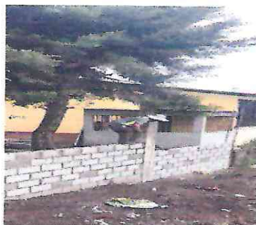
Foto 2 : Levantado de block y columnas.
