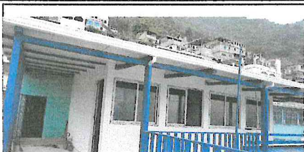
Fase final de la remodelación de la cocina
