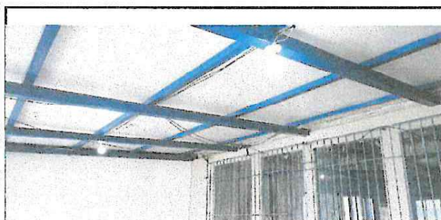
Instalación de energía eléctrica en el área de cocina
