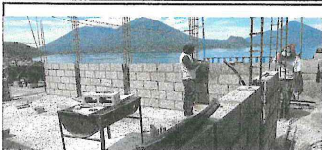
Reparación de paredes del área de cocina
