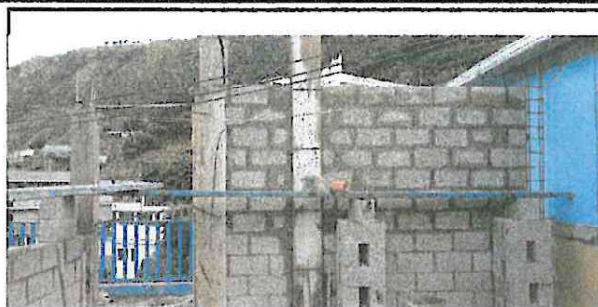
Seguimiento en la reparación de paredes del área de cocina
