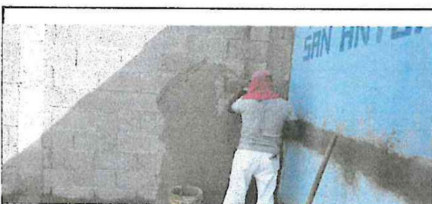
Inicio de repello de paredes del área de cocina
