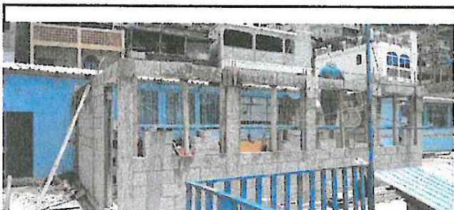
Anivelando paredes del área de cocina
