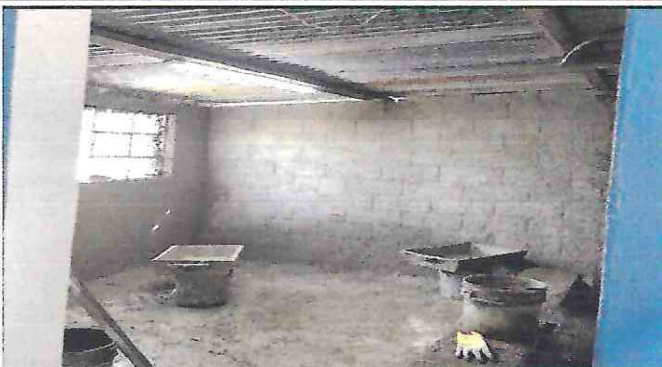
Foto 2: Reparación de piso
