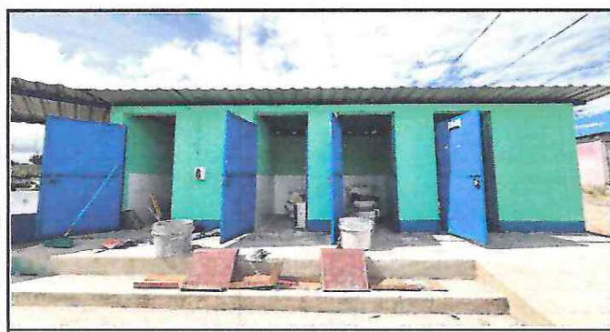
Foto 5: Reparación de piso antideslizante
