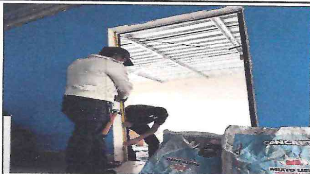
Foto1: Sustitución de puerta de metal
