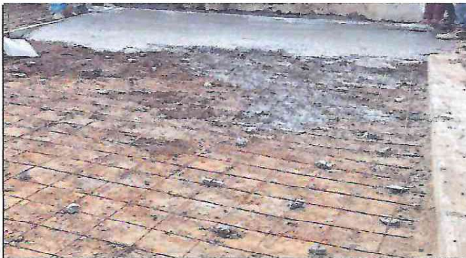
Foto 4: Reparación de patio
