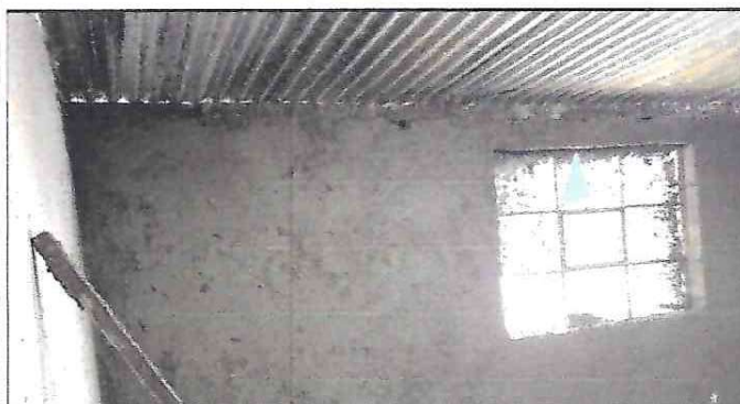
Foto 3: Reparación de pared
