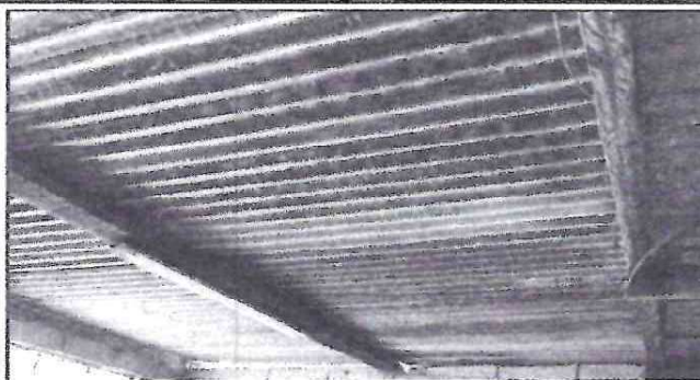
Foto 1: Reparación de techo
