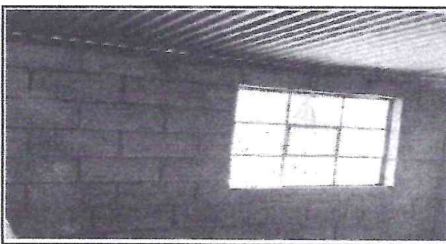
Foto 6: Reparación de ventana y balcón
