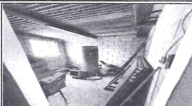
Foto 2: Reparación de piso
