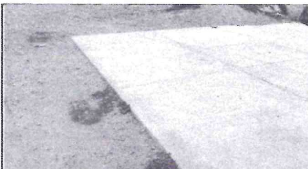
Foto 4: Reparación de patio
