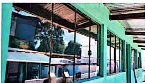
FOTO 3; INSTALACIÓN DE BALCONES
