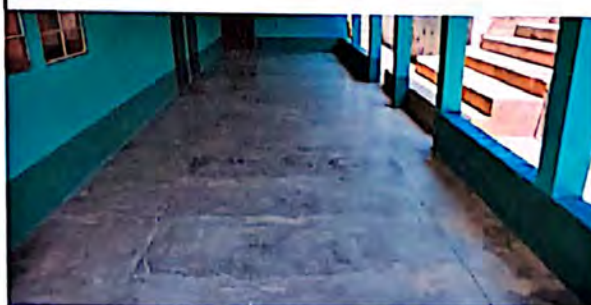
FOTO 6: SUSTITUCIÓN DE PISO DE CONCRETO A PISO CERÁMICO EN EL CORREDOR
