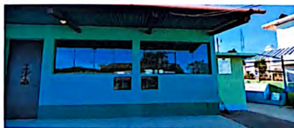
FOTO 5; INSTALACIÓN DE BALCONES
