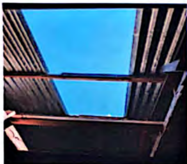
Foto1: INSTALACIÓN DE LÁMINA
