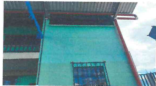
Foto 2: Canales y bajadas de agua
