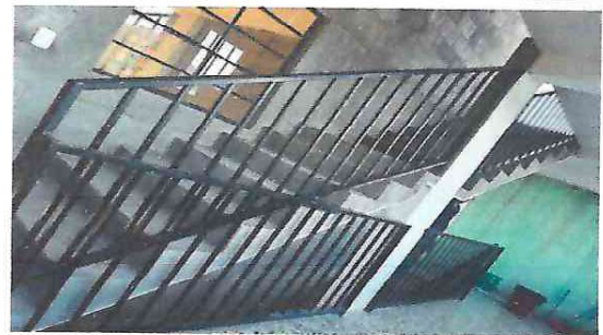
Foto 4: Mantenimiento a barandas
