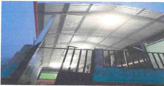
Instalación del sistema eléctrico
