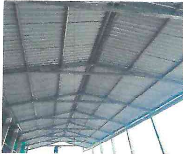
Foto 1: Estructura de techo de patio
