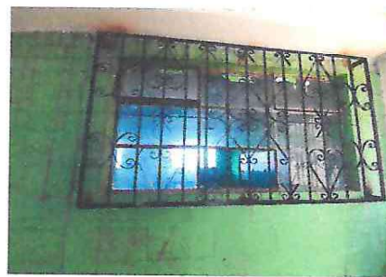
Foto 6: Mantenimiento a ventanas
