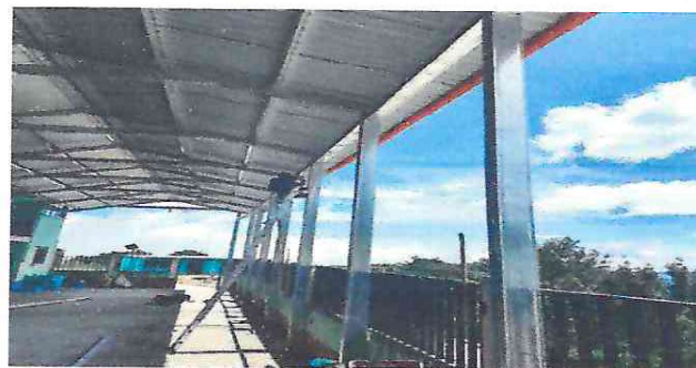
Foto 2: Canales y bajadas de agua
