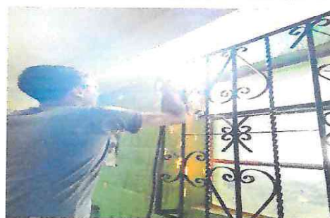
Foto 6: Mantenimiento a ventana
