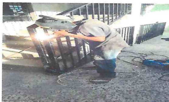
Foto 4: Mantenimiento a baranda
