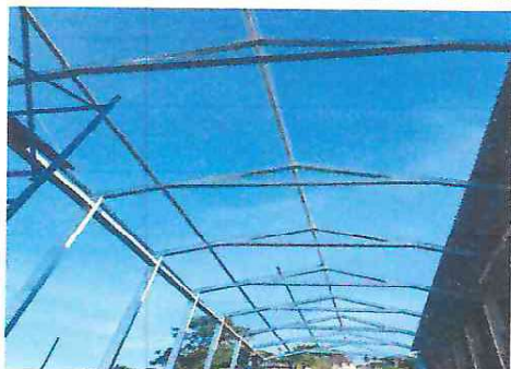
Foto 1: Estructura de techo de patio
