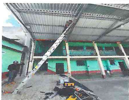
Foto 3: Instalación del sistema eléctrico
