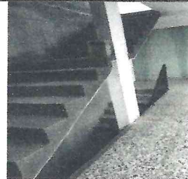
Foto 4: Mantenimiento a baranda.
