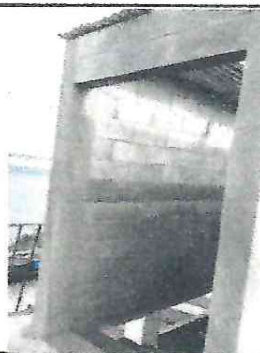
Foto 5: Mantenimiento a portón.
