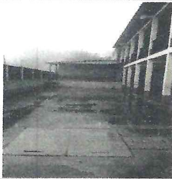
Foto1: Estructura de techo de patio
