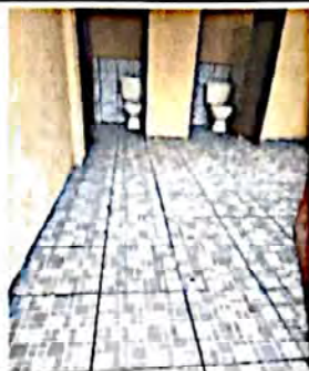
Foto 1: Piso cerámico colocado en los sanitarios de niños y niñas.
