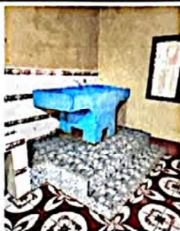
Foto 7: Pila instalada dentro del espacio de la cocina
