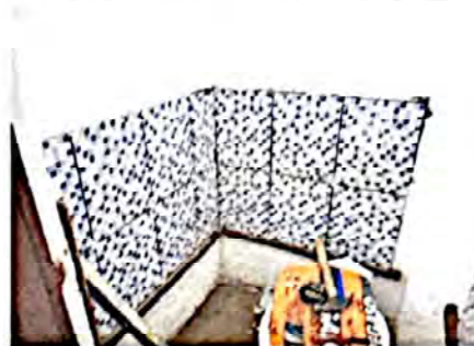
Foto 2: Colocación de azulejo en sanitarios de niños y niñas.
