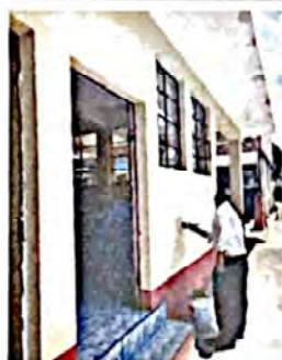
Foto 3: Proceso de pintar paredes en los sanitarios de niños y niñas.
