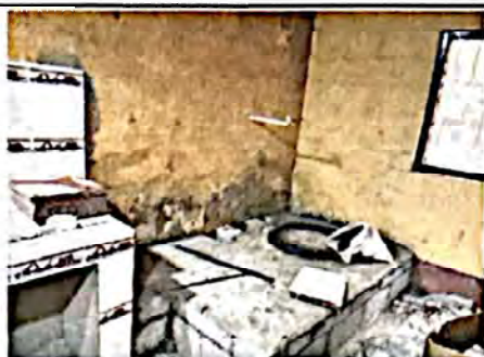
Foto 7: Construcción del área para la instalación de la pila dentro de la cocina
