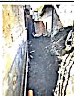
Foto 8: Proceso de repello de la pared en la parte de atrás de la cocina.
