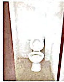
Foto 2: Colocación de azulejo en sanitarios de niños y niñas.
