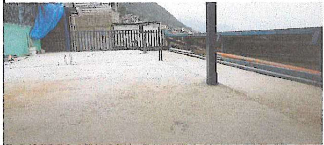
Reparación de losa terminado
