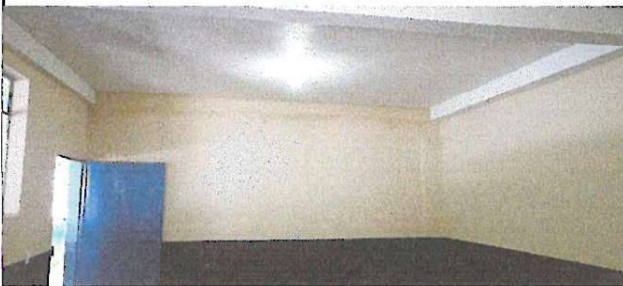
Acabados repello y cernido de la parte inferior del patio de losa (dentro de los salones)
