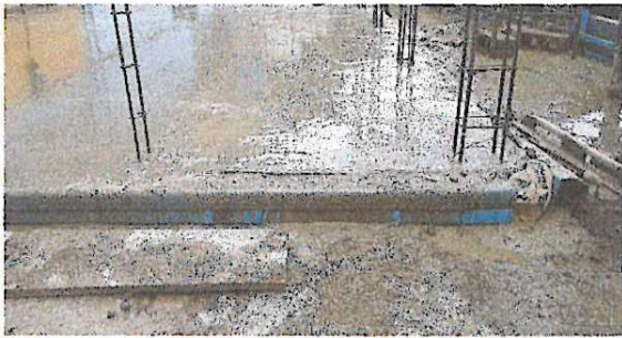
Patio de losa terminado
