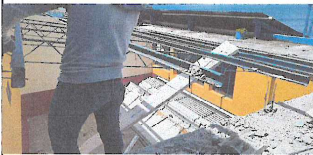
Desmontaje del techo antiguo
