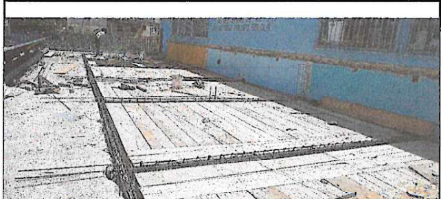
Entarimado para hacer la armadura de hierro que sostendrá el patio de losa
