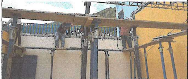
Instalando el entarimado para el patio de losa.
