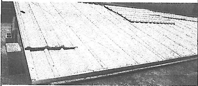
Foto 3: Levantamiento de láminas para colocación de losa de patio, desde otra perspectiva
