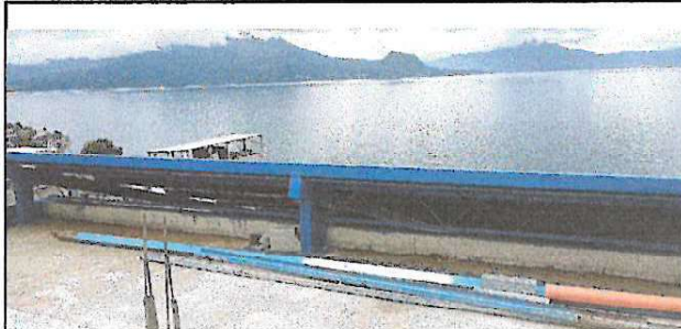
Instalación de protección en el techado antiguo (filo de la lámina)
