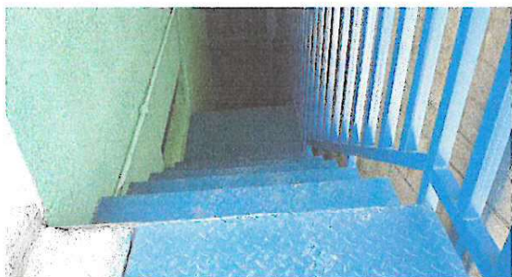
Culminación de la instalación de gradas para el ingreso al área de cocina
