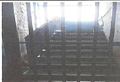
Instalación pintado de una puerta de rejas para el ingreso de gradas para el área de cocina
