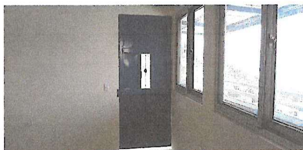
Instalación de 2 puertas de metal y cuatro ventanas de PVC
