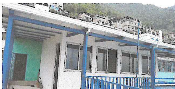
Culminación del techo de cocina parales y baranda pintadas.
