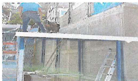
Instalación de techo en gradass
