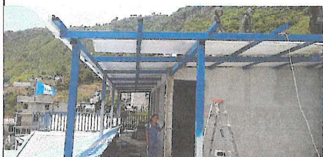
Inicio de la instalación del techo en la cocinass
