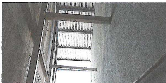
Instalación del techo sobre gradass
