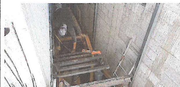
Inicio de instalación de gradass de ingreso al área de cocinass
