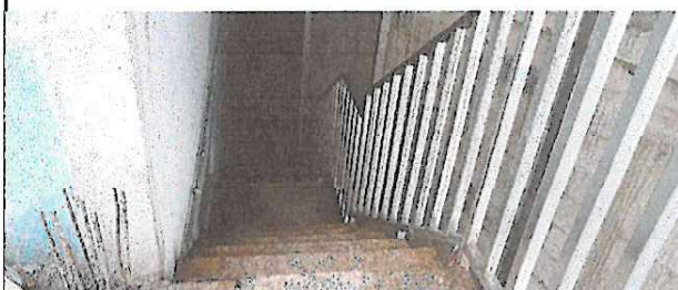
Colocación de barandas a las gradass de ingreso al área de cocinass
