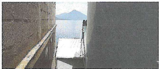
Foto 4: Espacio donde se instalarán las gradas para ingresar a la cocina, desde otra perspectiva
