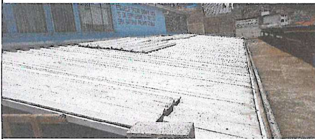
Foto 1: Reparación del techo para la cocina
