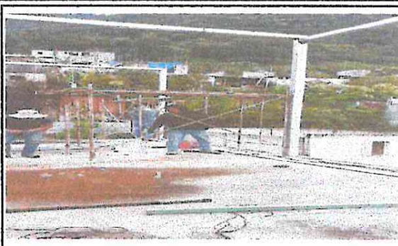
Foto 2: Armazon de la estructura
