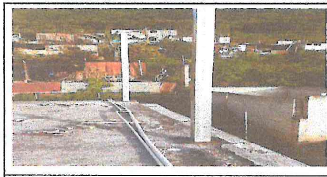
Foto 5: Ubicación de columnas
