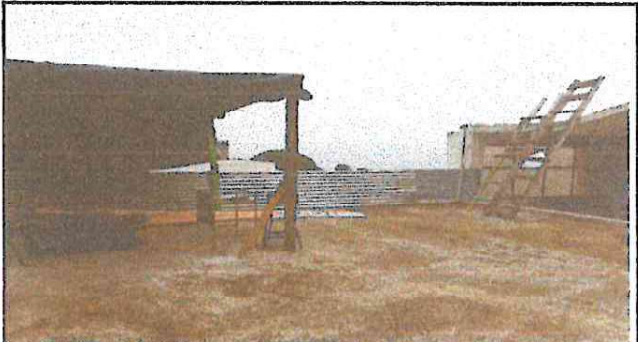
Foto 4: La galera cubre únicamente parte del área del centro educativo
