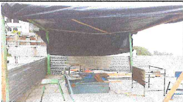
Foto 1 Se observa galera para resguardo de escritorios de terlorados
