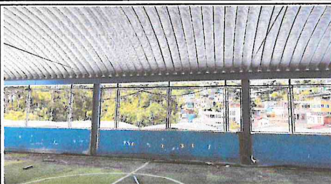
Foto 1: Columnas y vigas instaladas.
