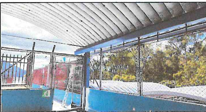
Foto 3: Columnas y vigas ensambladas a la estructura existente.
