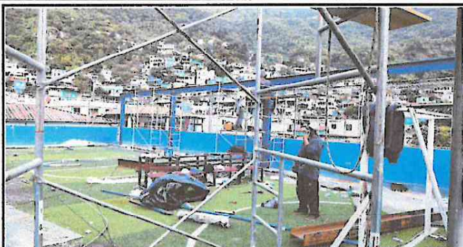
Foto 1: Colocación de Columnas y vigas.
