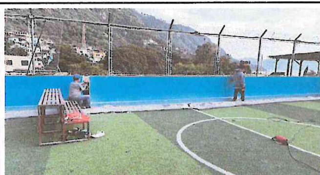
Foto 2: Apertura de espacio para colocación de columnas.
