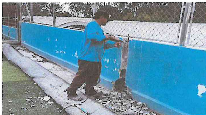
Foto 4: Instalación de columnas.
