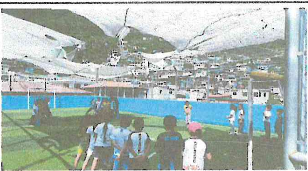
Foto 6: Tela deteriorada por calor y uso frecuente.
