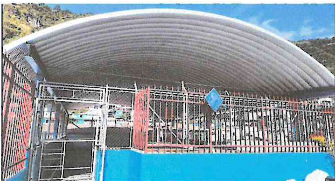
Foto 3: Cubierta instalada completamente.
