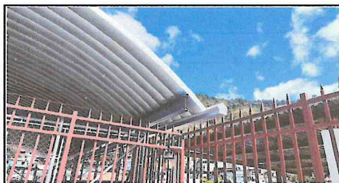
Foto 4: Canales fluviales ensambladas a la cubierta.
