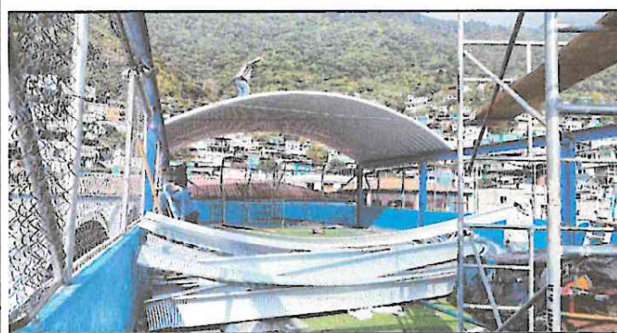
Foto 5: Cocolación de tensores.
