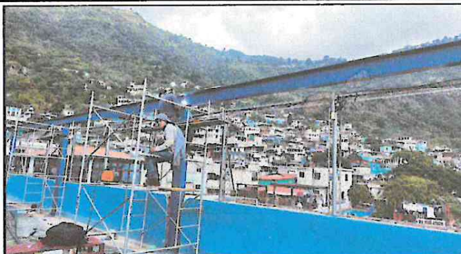
Foto 2: Ensamblaje de vigas.
