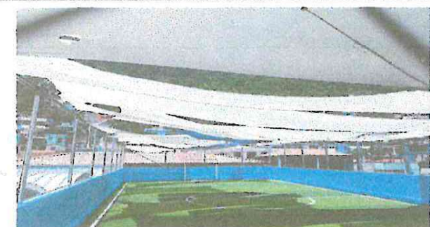
Foto 5: Protector de cancha desgastada.
