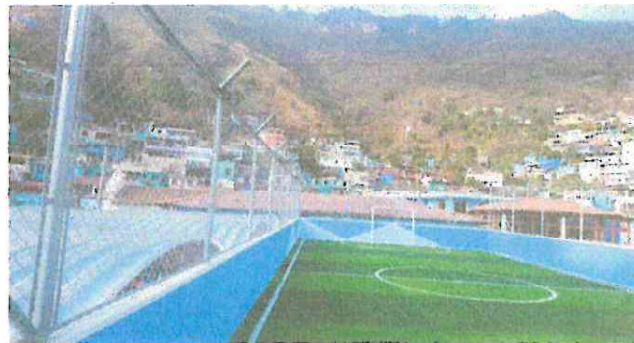
Foto 2: Cancha expuesta a la intemperie por falta de cubierta.
