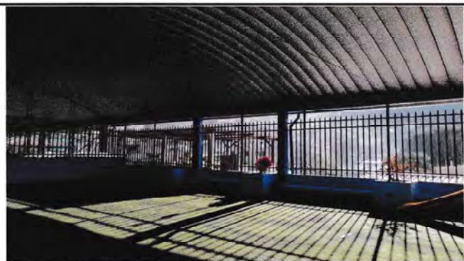
Foto 1: Techo terminado lateral este
