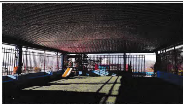
Foto 2: Techado terminado lado sur
