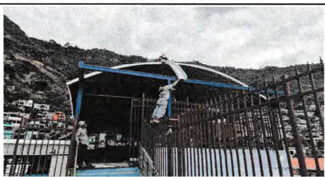
Foto 6: Instalación de láminas rompevientos
