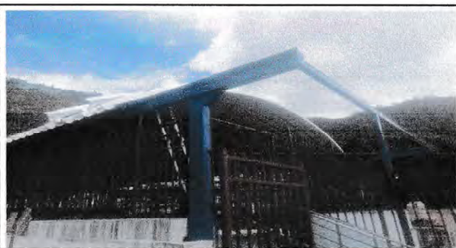
Foto 5: Instalación de láminas curvas
