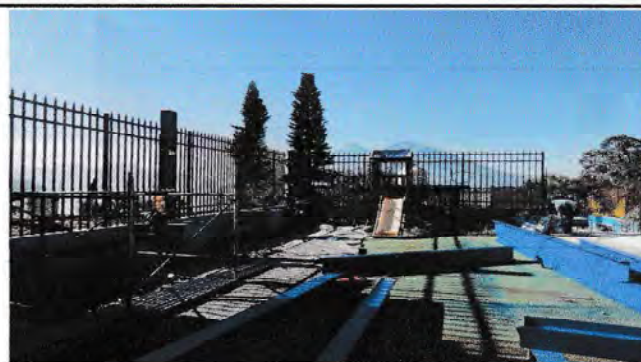
Foto 2: Fabricación y pintada de vigas
