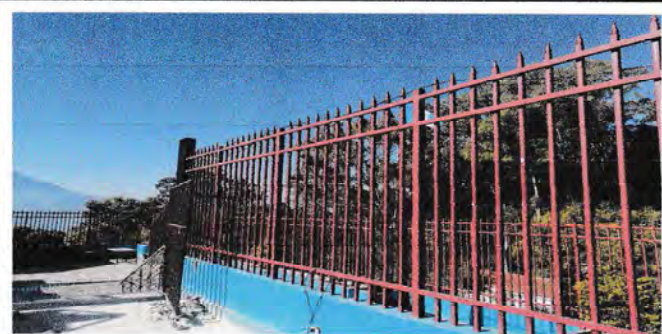
Foto 5: Vista de la entrada hacia el área con barandales para el ensamble de columnas.
