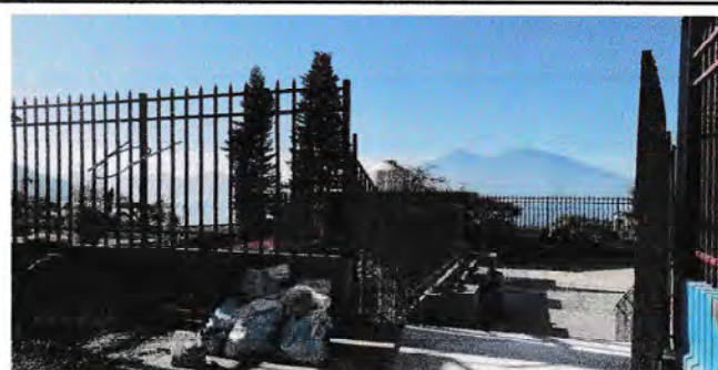
Foto 6: Vista del portón para la entrada principal.
