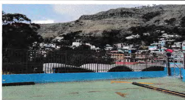
Foto 4: Vista del lateral del área para ensamble de columnas de metal.
