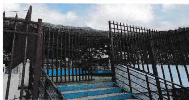
Foto 3: Entrada principal al área a intervenir, cambio de porton improvisado a porton nuevo, corredizo con chapa.
