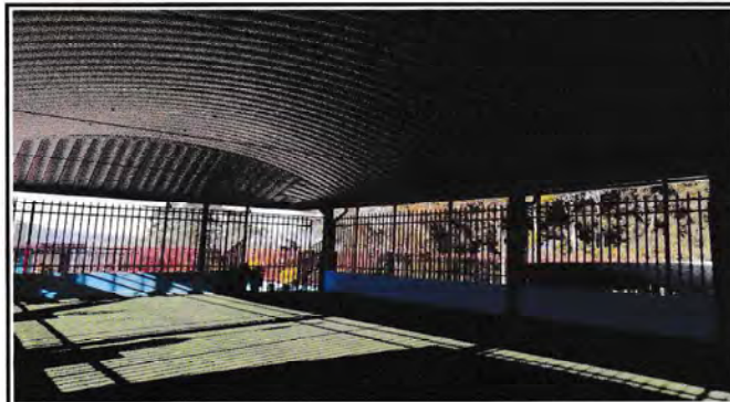
Foto 4: Entrada principal al área con portón corredizo
