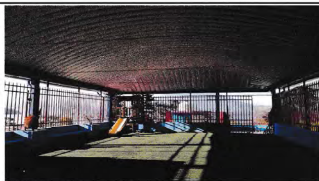
Foto 2: Techado terminado lado sur
