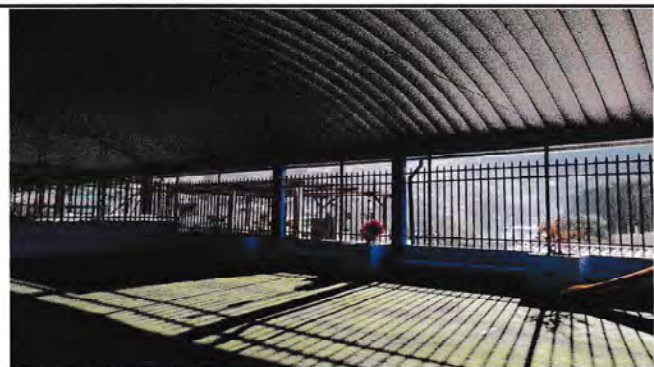
Foto 1: Techo terminado lateral este
