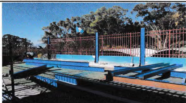
Foto 1: Fabricación e instalación de columnas.
