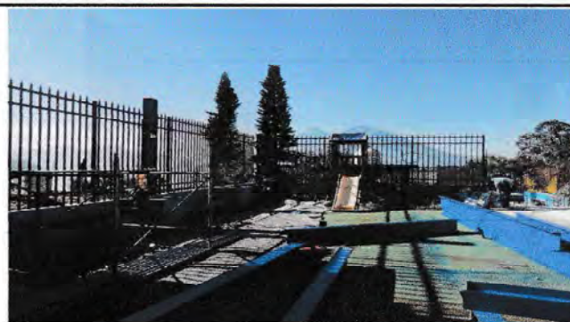
Foto 2: Fabricación y pintada de vigas
